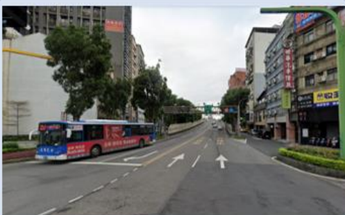
4. 中興橋引道(接康定路)現況
