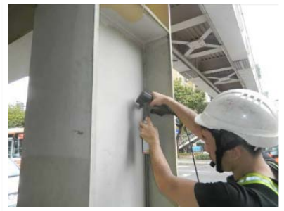
焊道磁粒檢測(師專附小人行陸橋)
