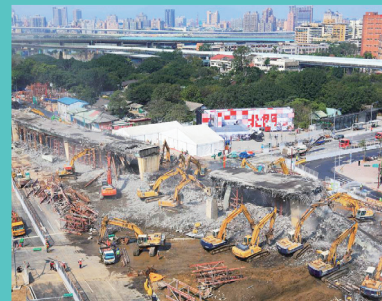
忠孝橋引橋拆除
