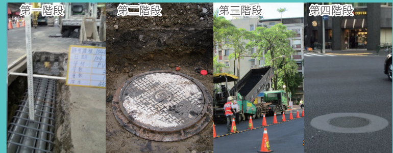
管線淺埋改善 路基改善及孔蓋調降 路面銑鋪 孔蓋提升
