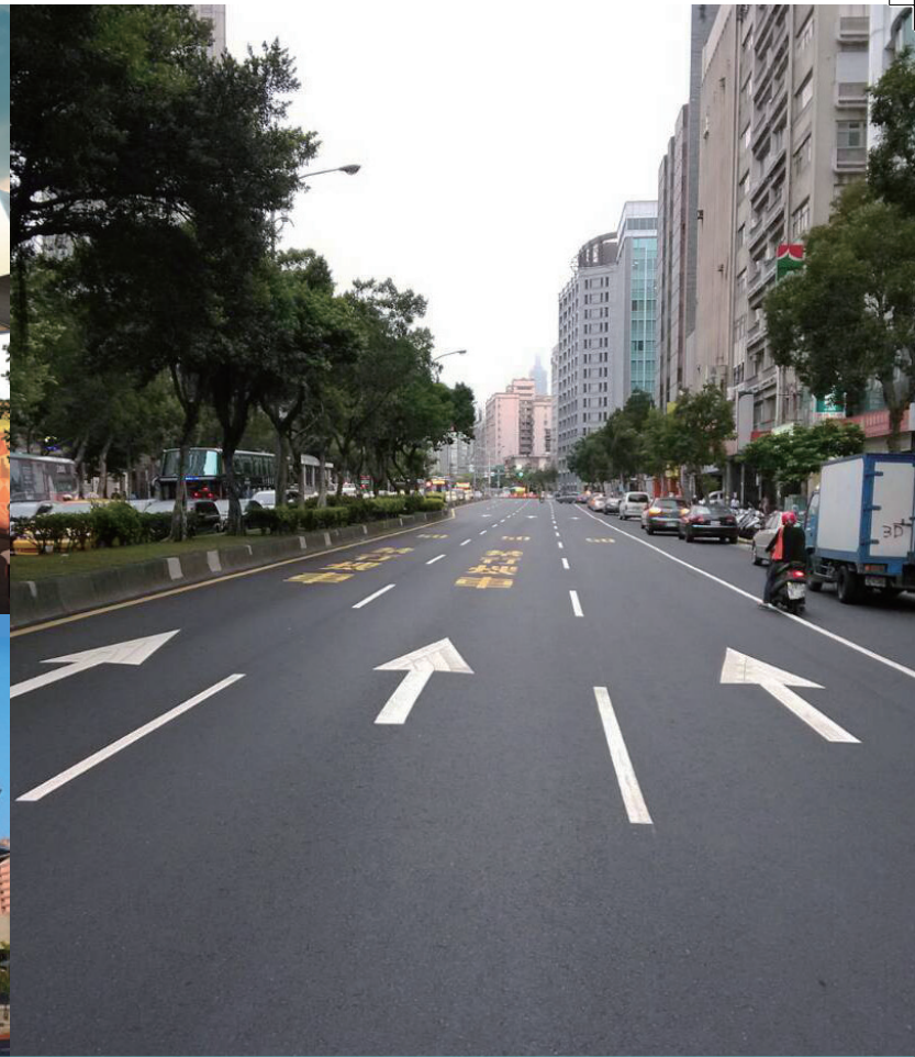
忠孝東路2段改善工程
