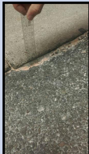
路面與溝體坑洞深度(+3.0CM)
