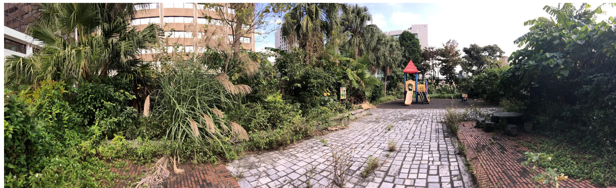
2 鋪面廣場雜草叢生
