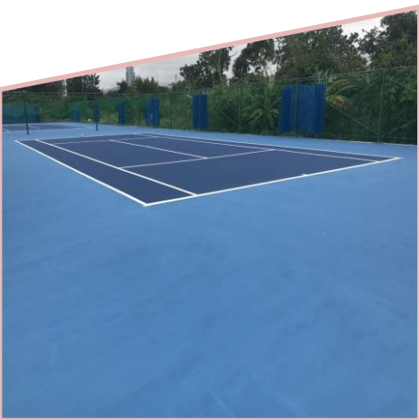
■ 河濱運動場地鋪面修護工程
