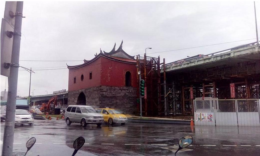
拆除引橋前橋下支撐與北門側架設U型保護鋼架隔屏情形
