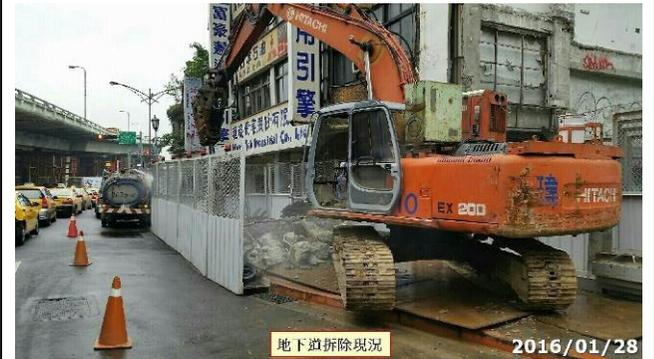
三井舊倉庫前人行地下道出入口封閉拆除作業之地下道空間灌漿填實
