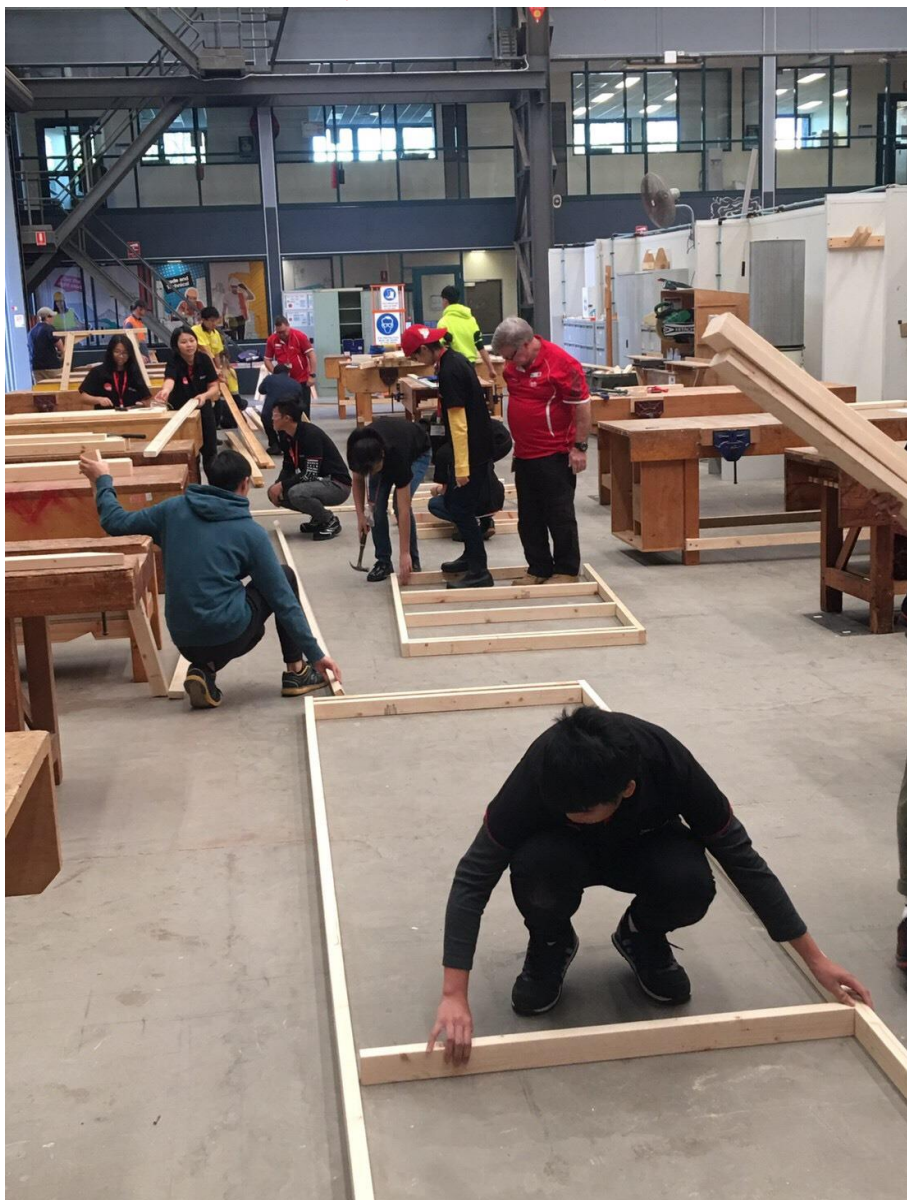
【圖 4-單面牆面及屋頂製作】
