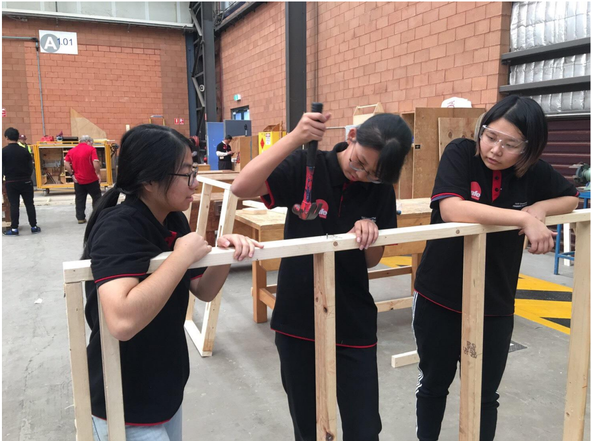
【圖 2-單面牆面及屋頂製作】
