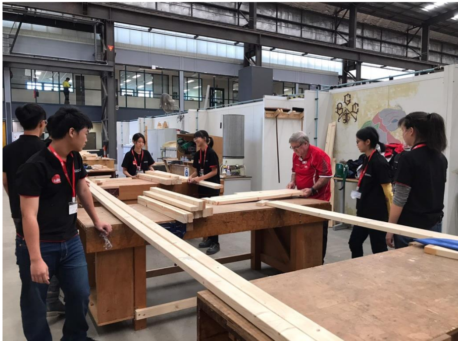
【圖 3-單面牆面及屋頂製作】
