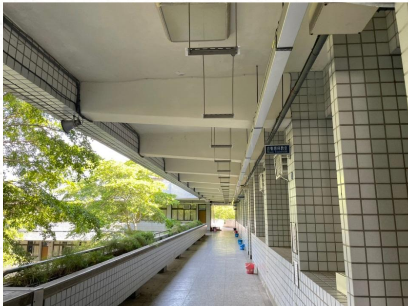
線槽吊架施作
