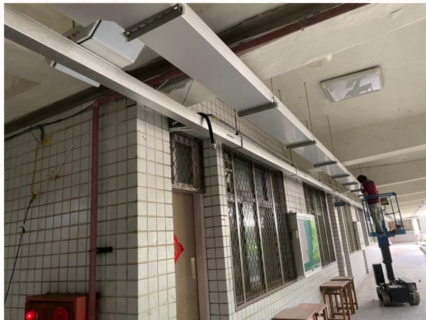
線槽安裝施作
