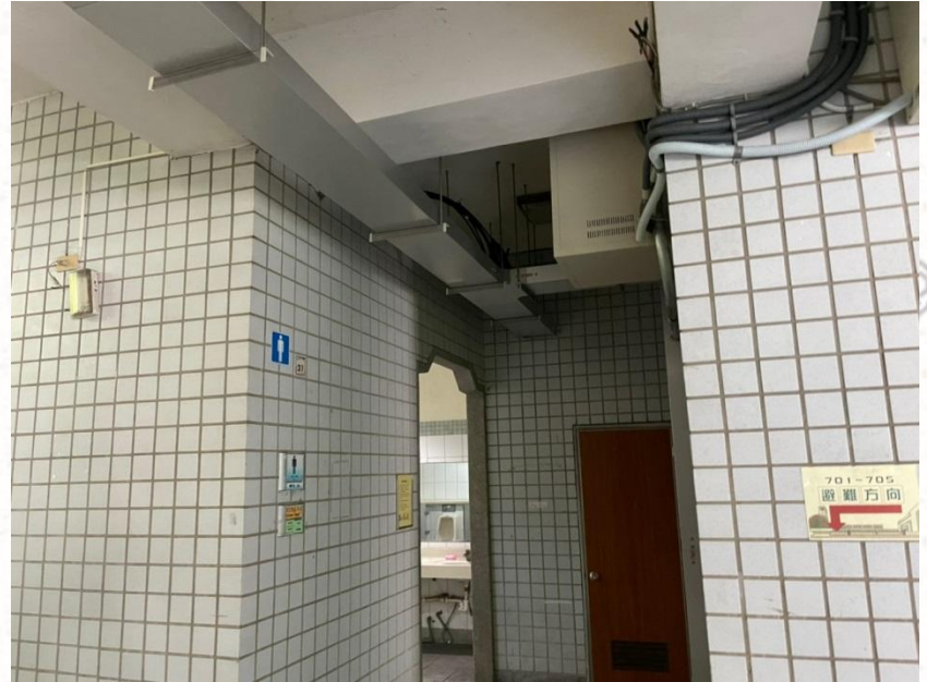
電纜佈置與樓層配電盤安裝
