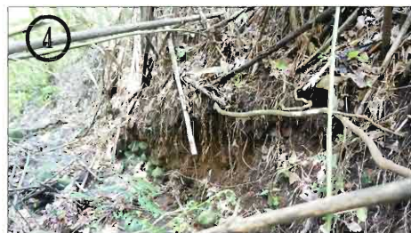
坑溝邊坡裸露，溝底多為塊石
