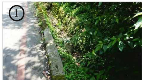
中興路旁排水溝匯入紫明溪
