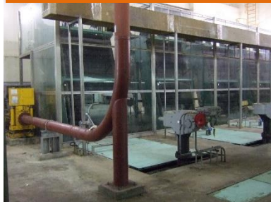
池槽、渠道密閉
