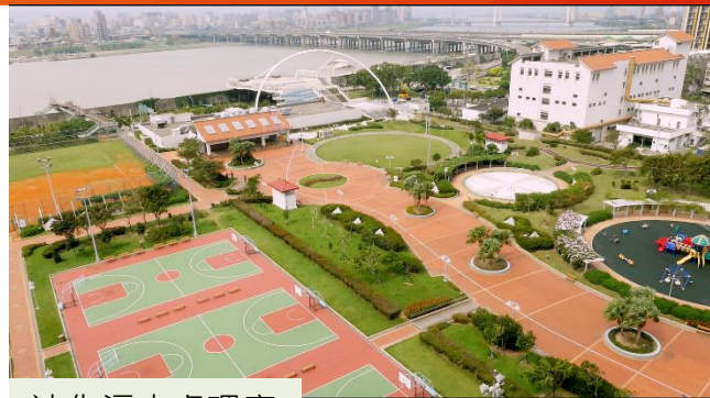
迪化污水處理廠
