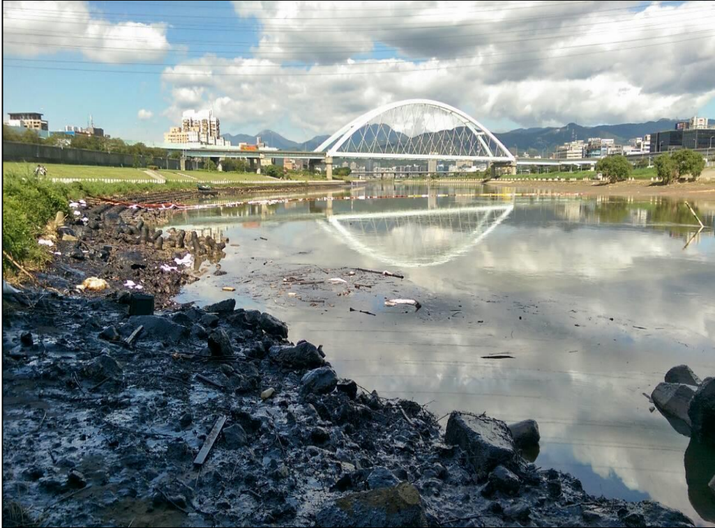
圖 20 麥帥二橋附近改善前情形
