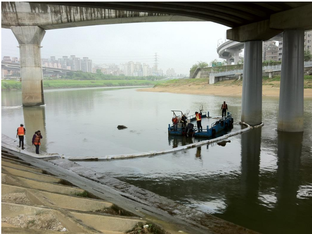
圖 4 環保局/水利處協力設置攔（吸）油索預防重油污染
