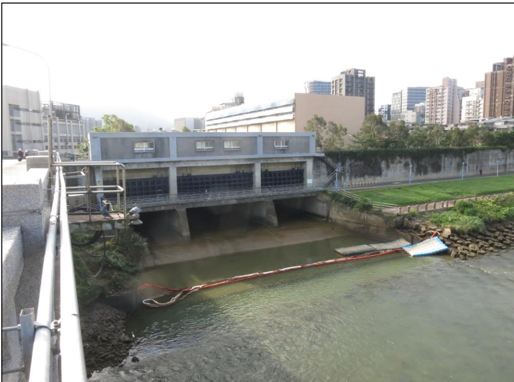
圖 15 玉成抽水站改善後情形
