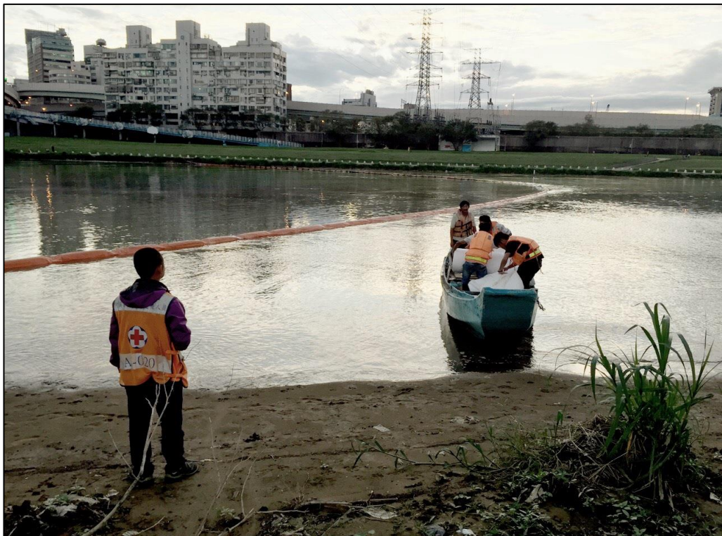
圖 7 麥帥一橋下攔油索設置作業情形
