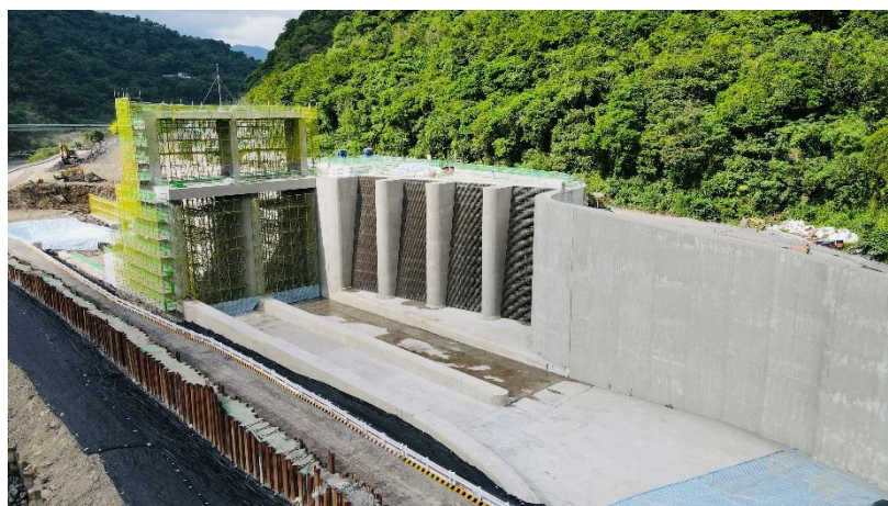
取水口引水路及排砂道
