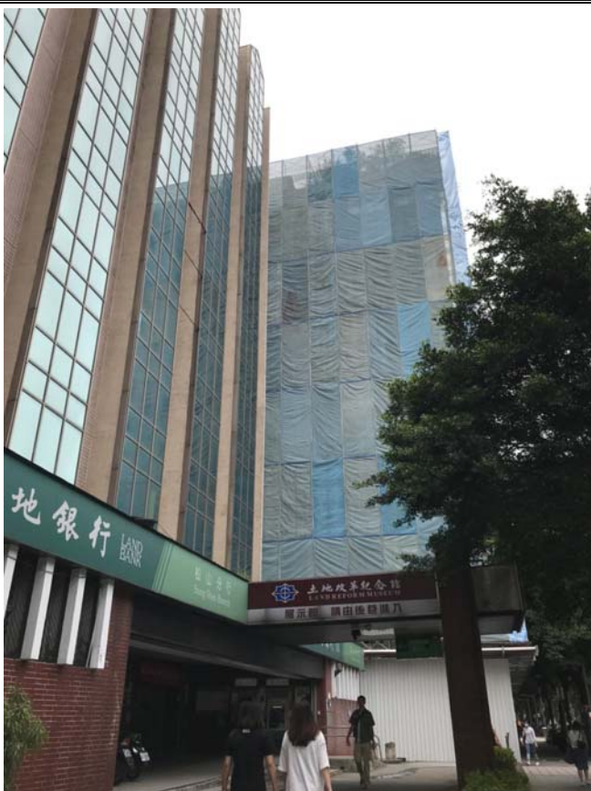
拆除前舊建物全棟先以鷹架及帆布包覆，並設置固定式圍籬
