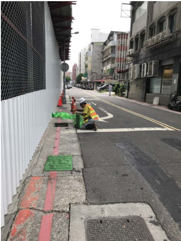
水溝蓋以網子包覆，避免泥砂排入
