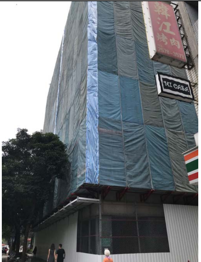
拆除前舊建物全棟先以鷹架及帆布包覆，並設置固定式圍籬
