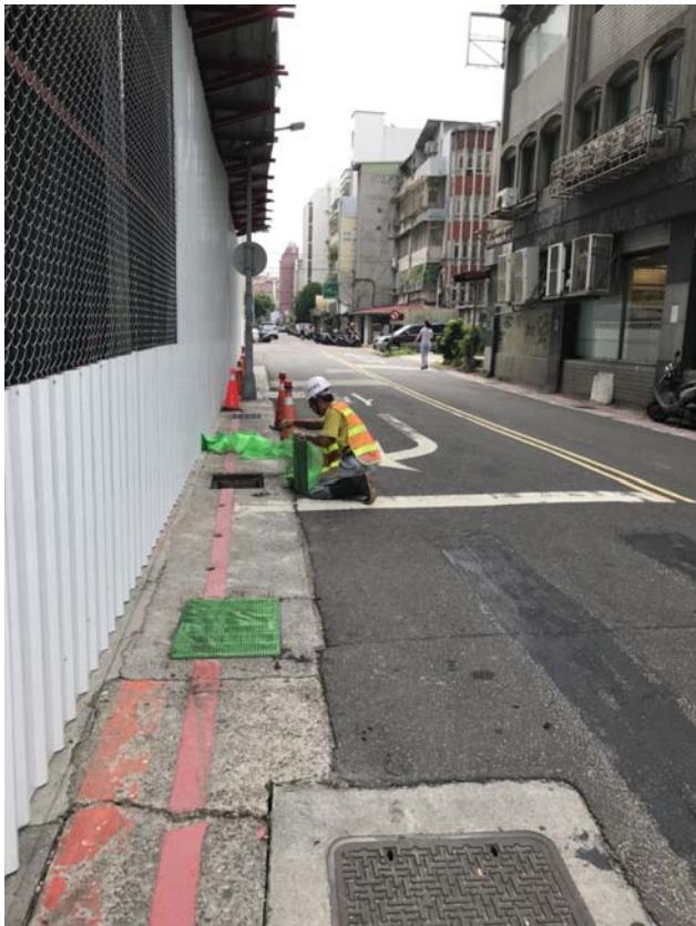
水溝蓋以網子包覆，避免泥砂排入
