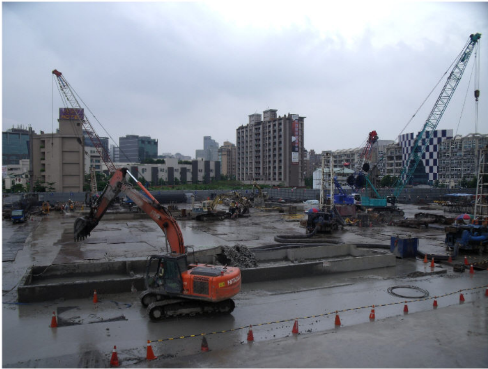
圖1-4 基地現況照片
