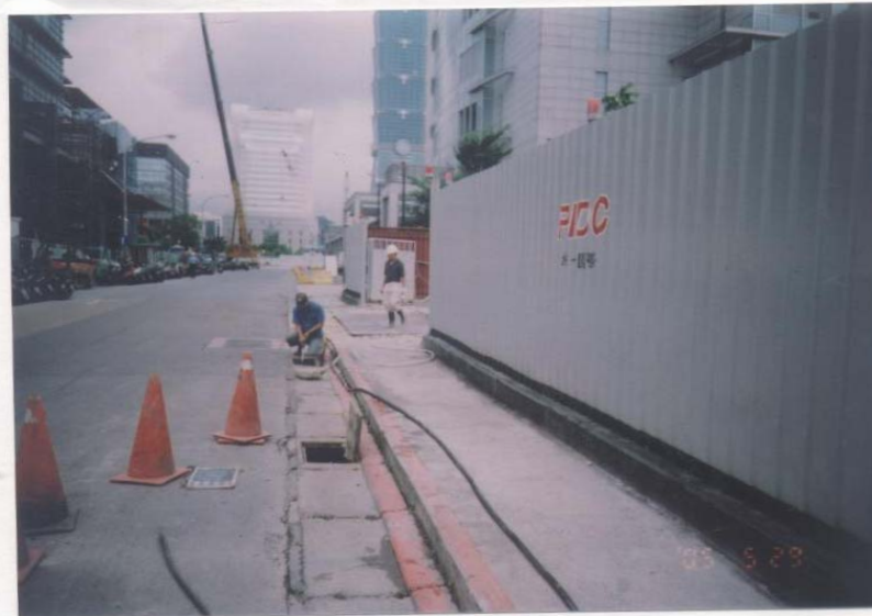
圖四 定期清理工地周邊水溝
