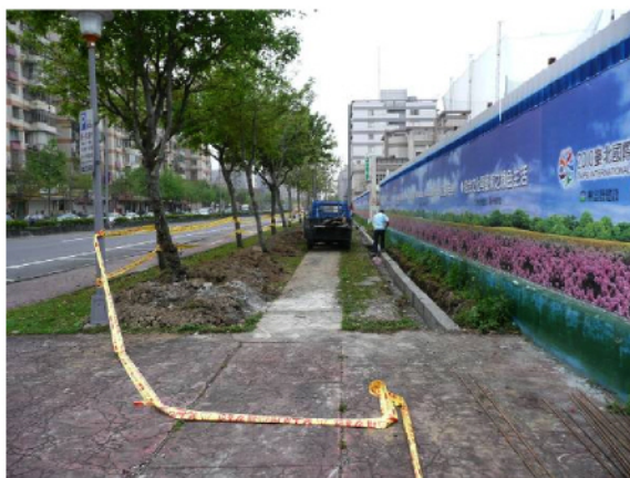
基地位於樂群二路上，現有鐵皮圍籬包圍，基地外圍綠化區正在進行施工(2010. 02. 27)。
