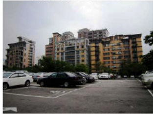
圖版 11 施工基地現況為收費停車場，停車場現皆鋪設柏油 地表，難以調查。(2011.5.21)
