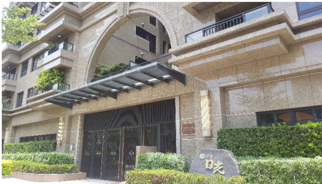
基地現況大門
