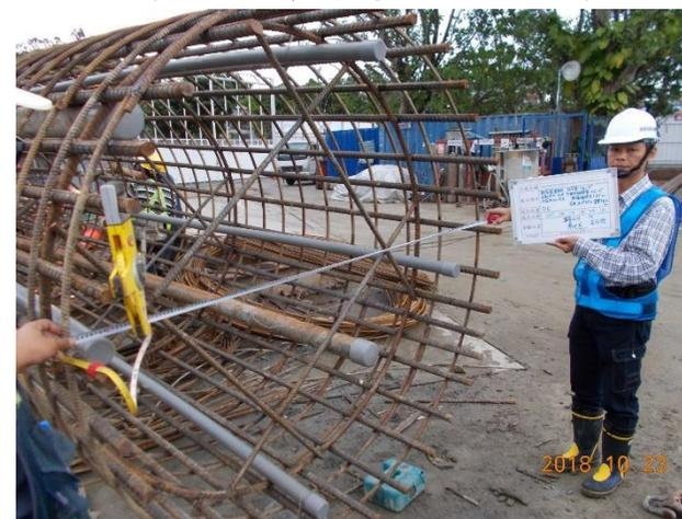
圖5.18 施工穩定性監測安裝
