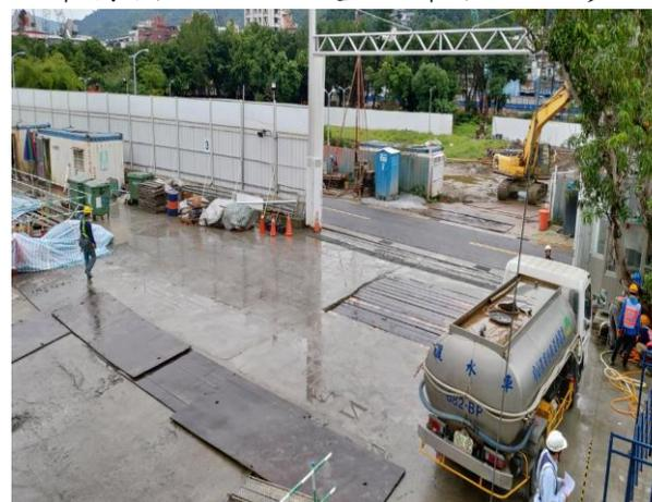
圖5.7 出入口設置洗車台
