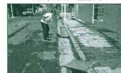
工區周圍人行道清掃
