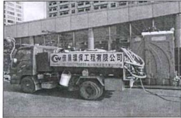
工區內設置流動廁所
