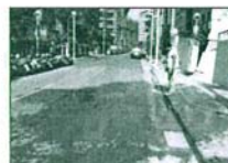
工區內外灑水
