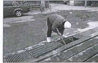
區外水溝清理
