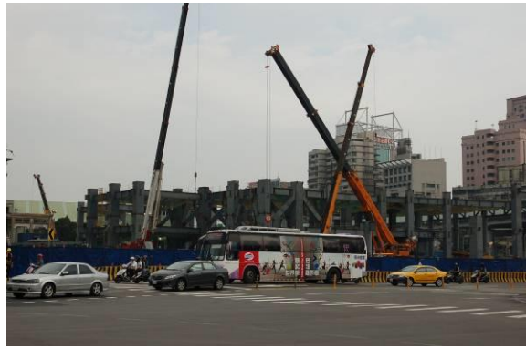
基地南側的鄭州路上有工程正在興建當中 (102.04.18)。
