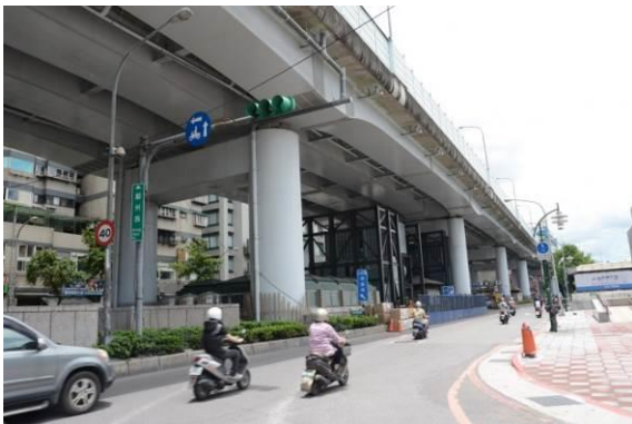
位於基地南側的鄭州路及市民大道高架橋，在上下班時間交通流量相當大 (103.05.24)。
