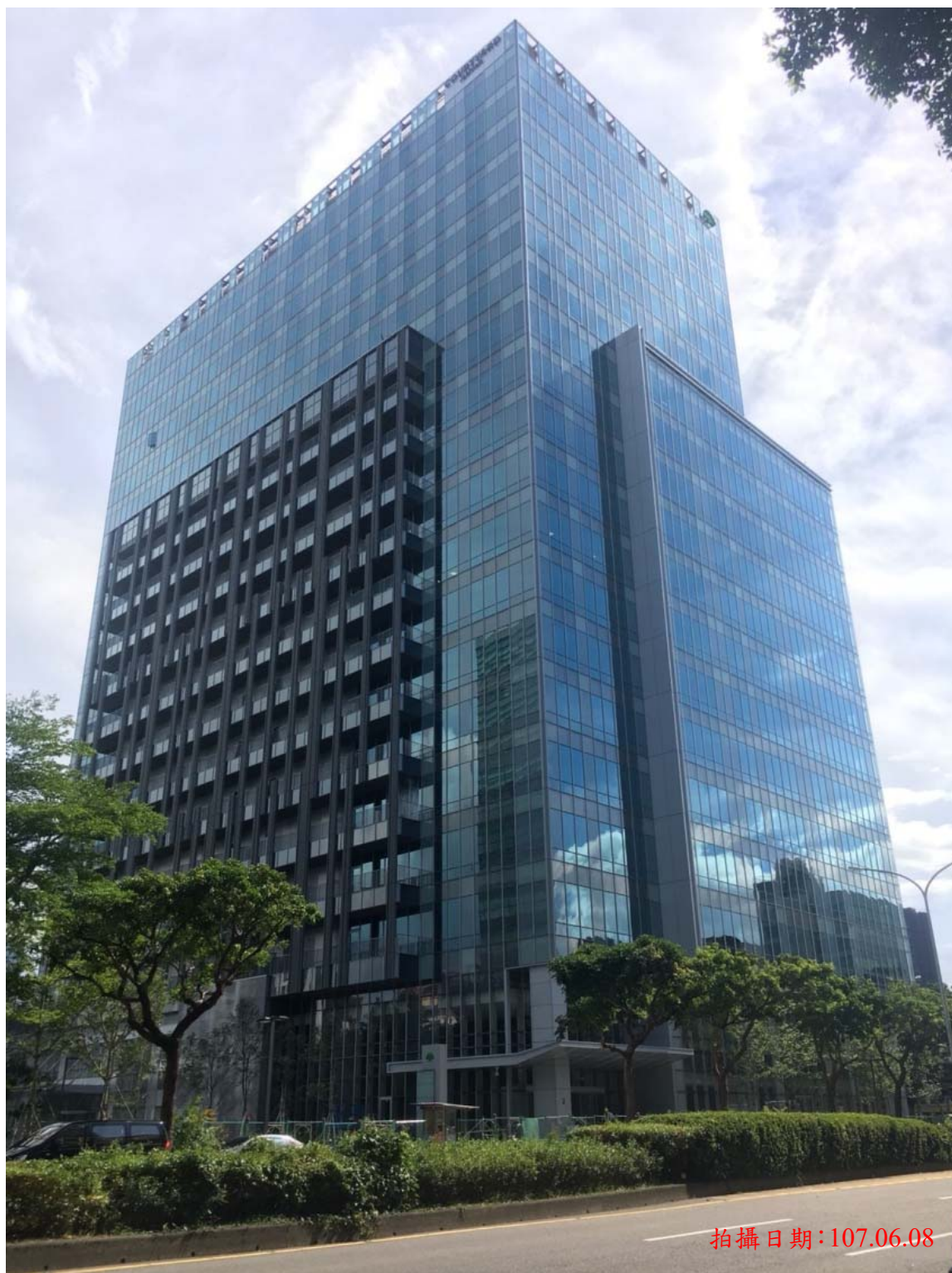
圖 3-2 開發基地周圍現況照
