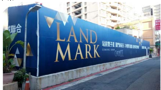
施工圍籬設置高度 4m
