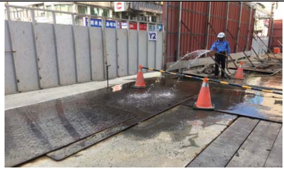
工地不定期灑水
