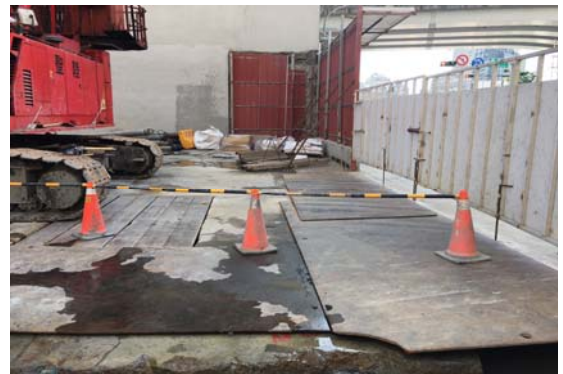
工地裸露地表鋪設鋼板及設置洗車設施
