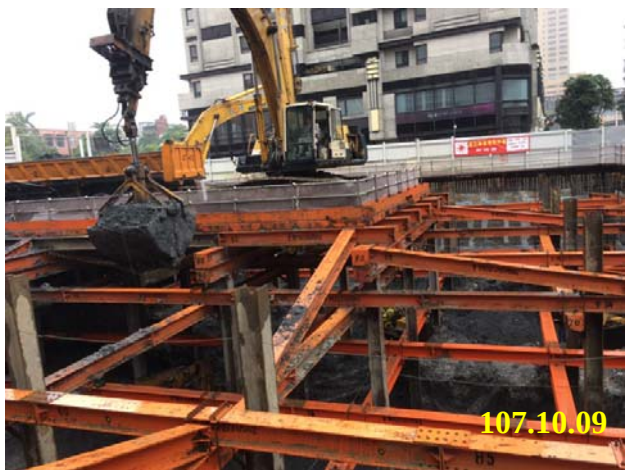
第三層土方開挖
