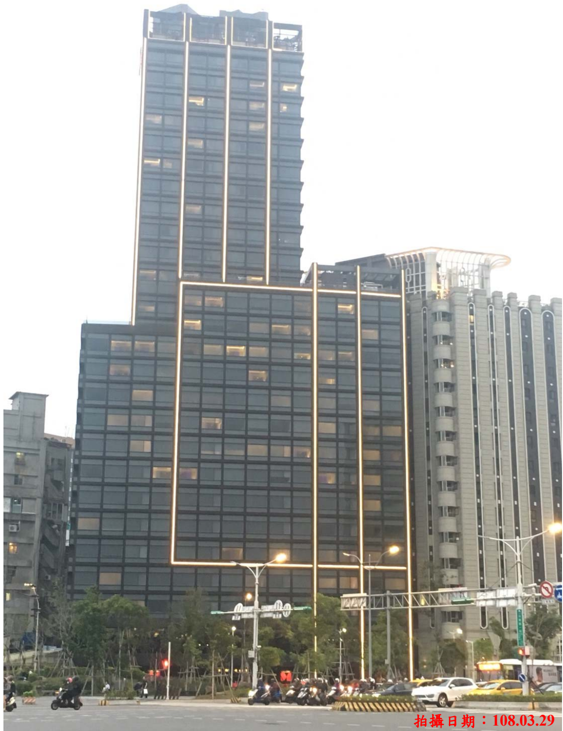
圖 3-2 開發基地周圍現況照
