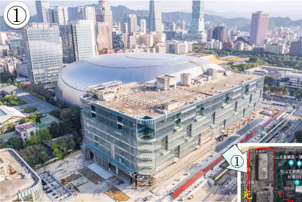
外觀現況照片
