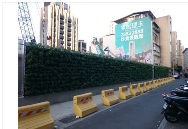
照片 1 施工圍籬綠美化
