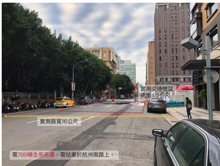
圖七-8 本次吊運以 700 噸全吊車進行吊運，需站車於杭州南路上，需事先申請路權
