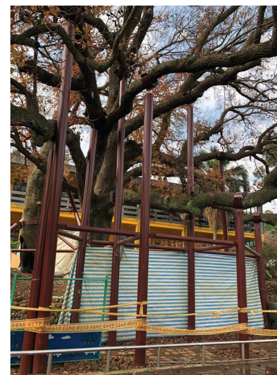
圖七-19 鋼構支撐架示意圖，鋼材支撐架應採暗色系，避免造成景觀視覺衝突
