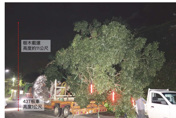
圖七-13 以全吊車將受保護樹木吊運至板車上
