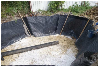
圖七-16 植穴周邊鋪放阻根板
