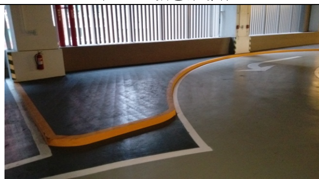
照片 14 道路鋪面與人行步道鋪面以色彩區隔
