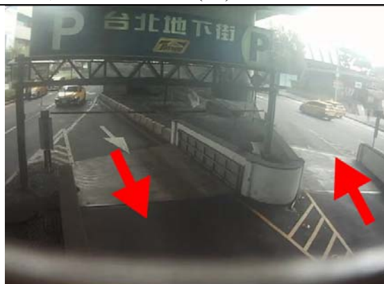
P3 市民大道地下街(東側)
