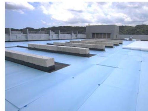
屋頂施作隔熱板
