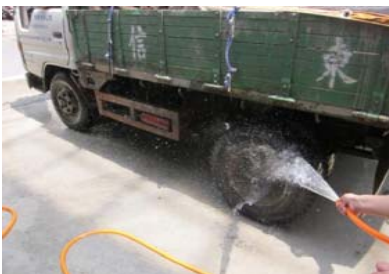
洗滌車輛或與土石機具之清洗措施
