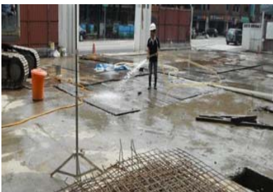
鋪設鋼板或打混凝土防塵
