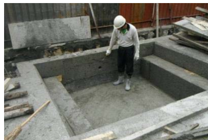
設置污泥沉澱池
