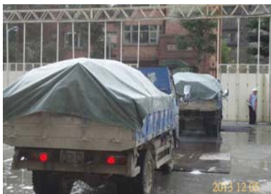
土石運輸車輛覆蓋不透氣塑膠布
