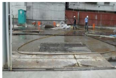
設置灑水噴霧措施
