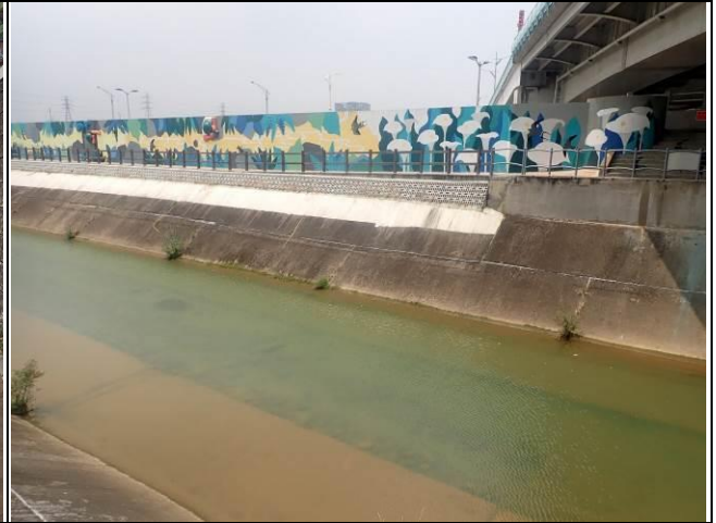
水域測站3環境現況
