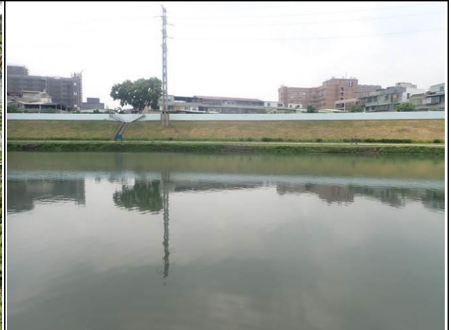
水域測站1環境現況
