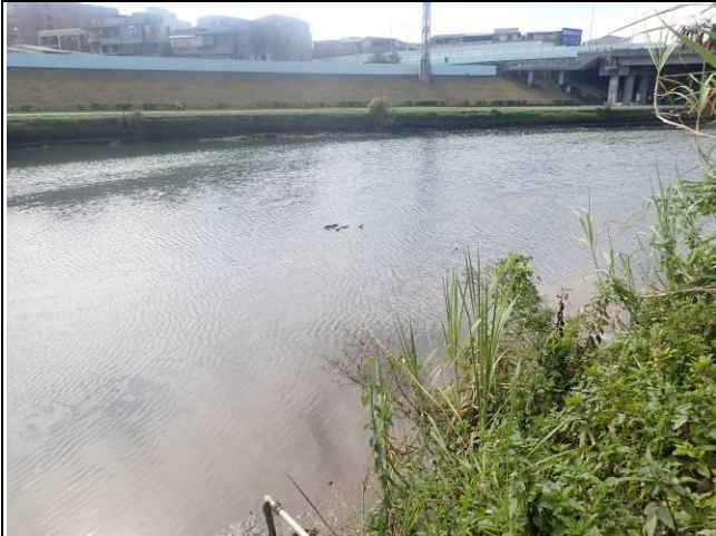
水域測站1環境現況
