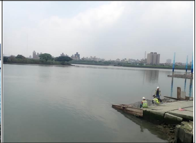
水域測站2環境現況
