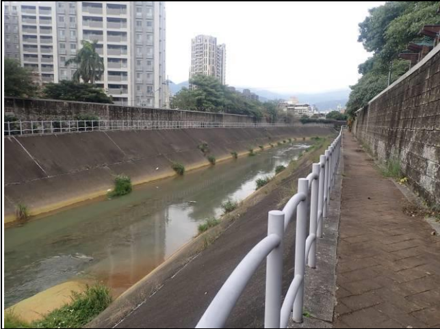
水域測站3環境現況
