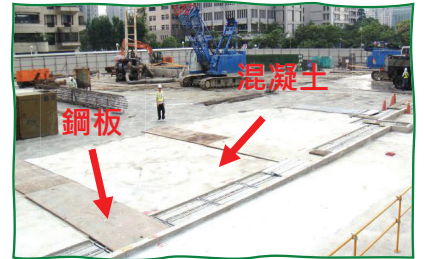
工區車行路徑鋪設混凝土或鋼板
