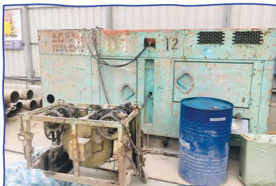
設置發電機與抽水機
