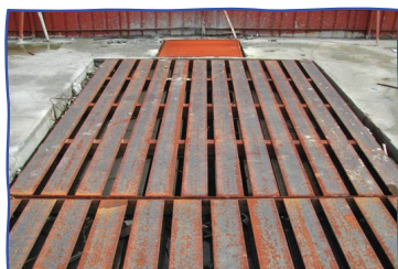
設置沉砂池及防溢座
