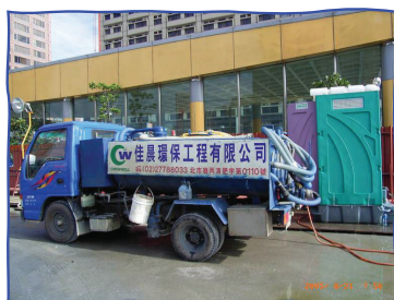
工區內設置流動廁所
