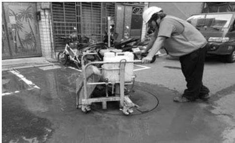
圖：更換耐揚壓孔蓋（圓形切割）
