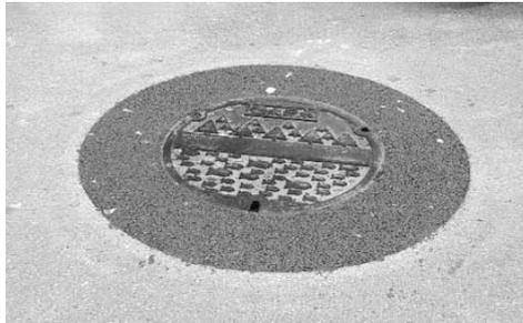
圖：耐揚壓孔蓋更換完成
