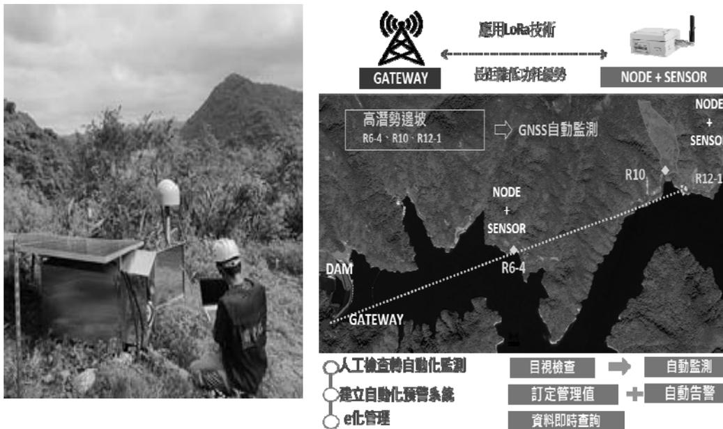
111 年裝設 GNSS 邊坡自動監測設備
