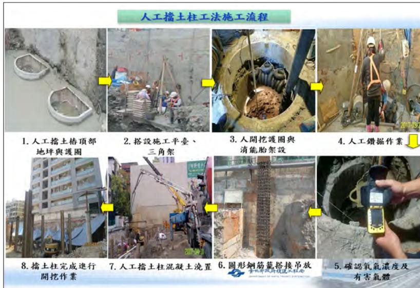
圖1-1 人工擋土樁施做流程
