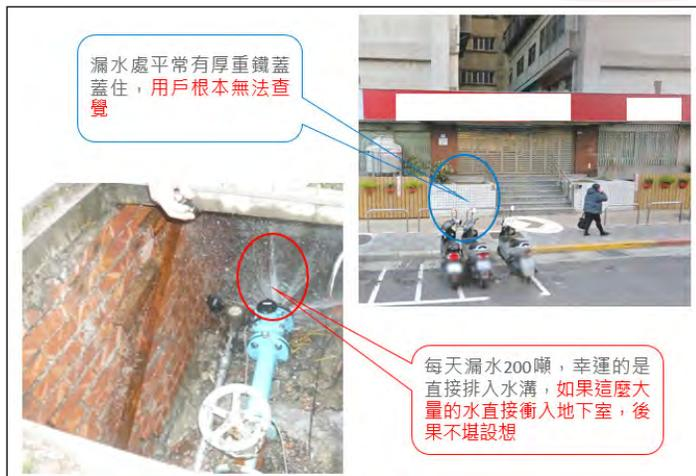
圖1-1 用戶不易發現管線或水栓損漏
