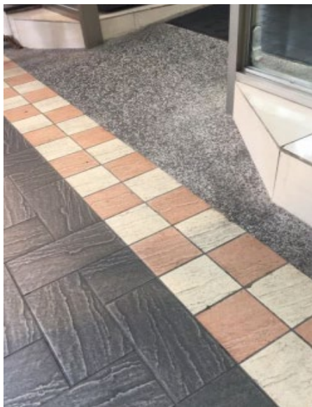
騎樓路段整體規劃設置視障者追跡線及選用具良好防滑性及耐污性之材質
