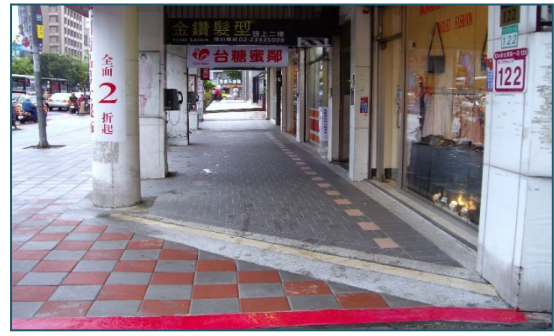
(整平後)路面順平，鋪面一致性
