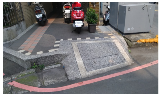
騎樓與馬路界面為坡道，但遭機車阻攔，輪椅者無法通行
