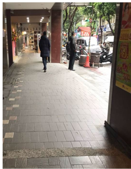
騎樓路段整體規劃設置視障者追跡線及選用具良好防滑性及耐污性之材質
