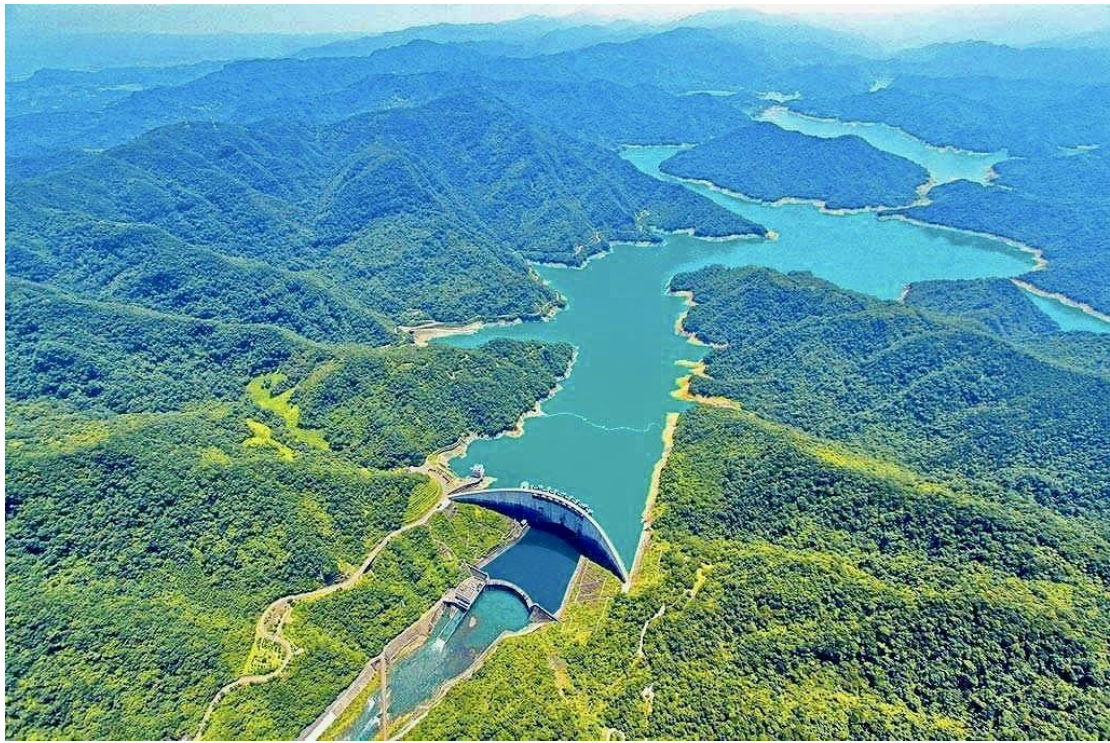
翡翠水庫攔截北勢溪水資源，主要功能：供水、發電、蓄洪防災
