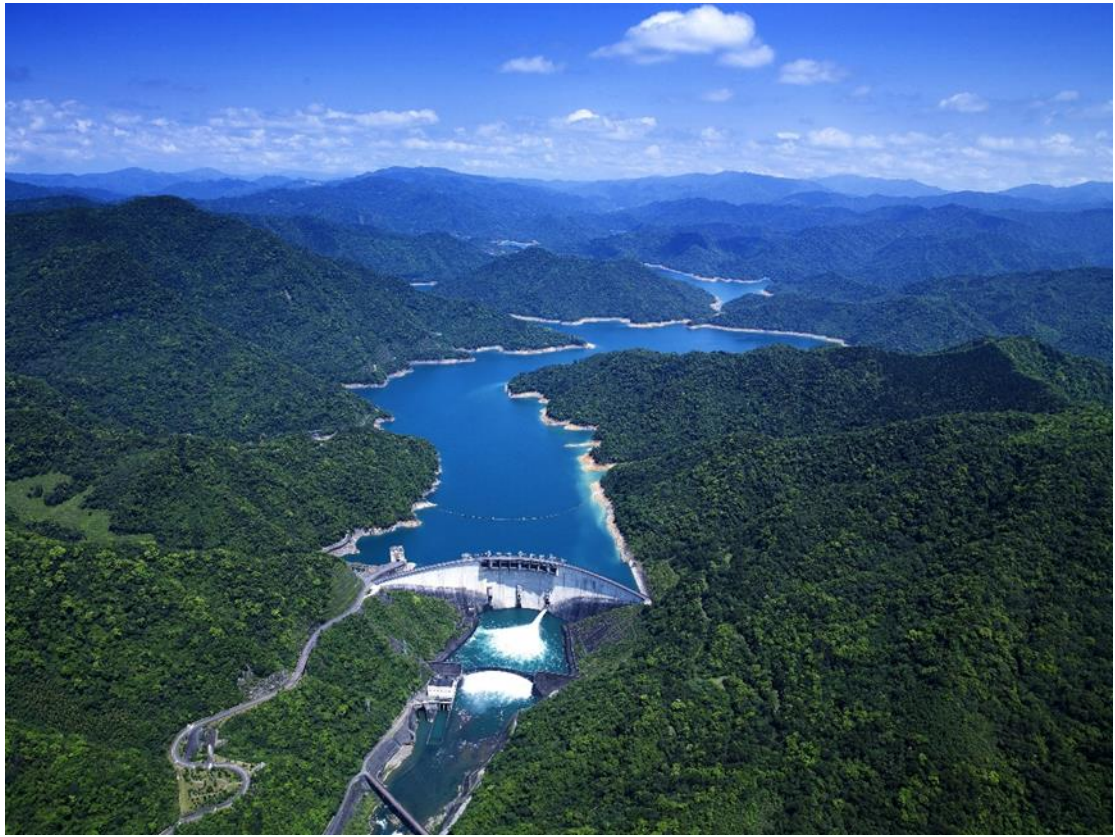
翡翠水庫庫區空拍照片
