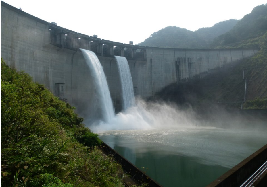
翡翠水庫「溢洪道」完成檢查及測試操作正常
