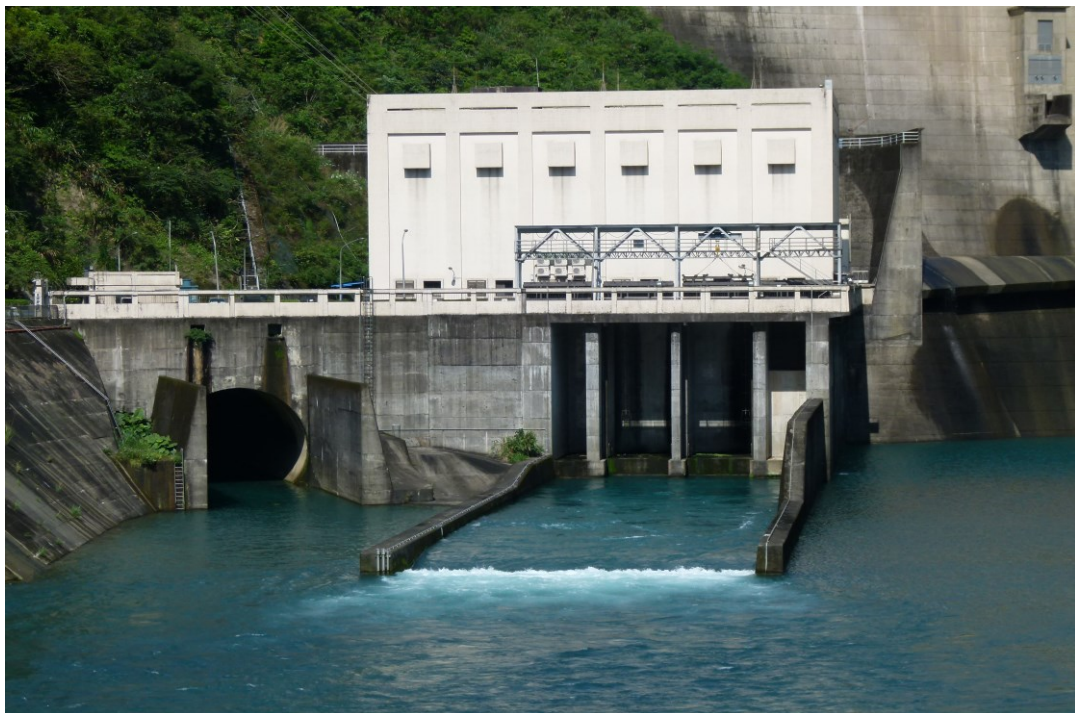
「排洪隧道(圖左)」、「發電廠出水口(圖右)」檢查測試正常
