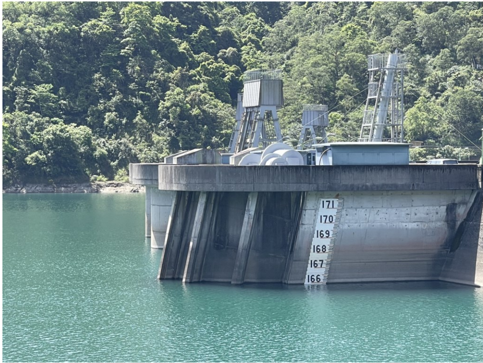
翡翠水庫「發電進水口」檢查及操作測試正常
