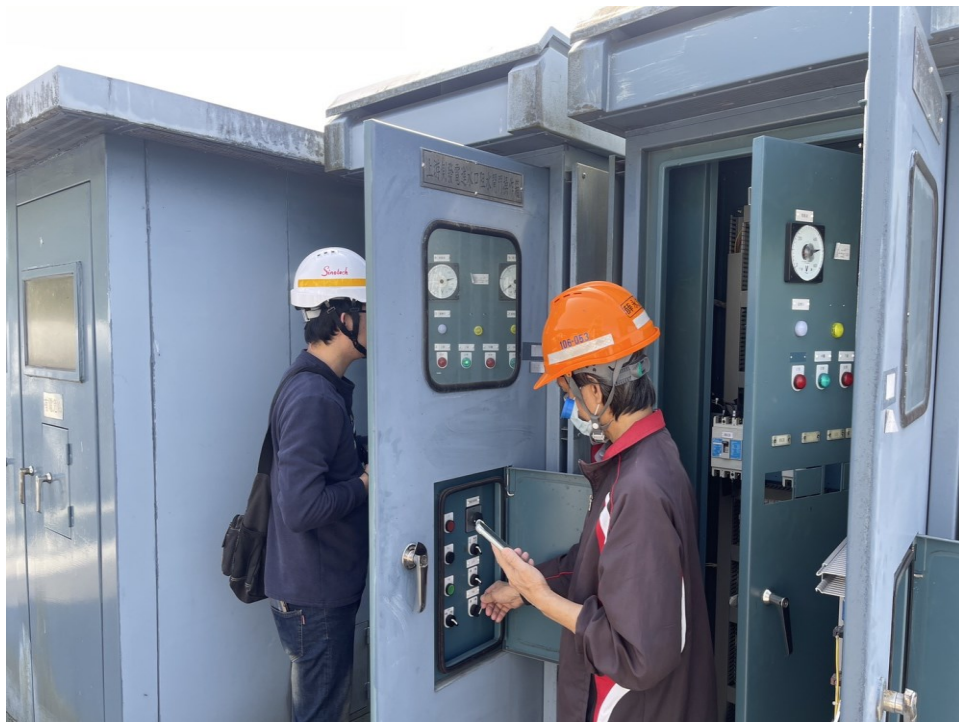
翡翠水庫「發電進水口」檢查及測試操作正常
