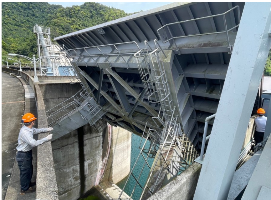
翡翠水庫溢洪道水工閘門已完成測試操作正常
