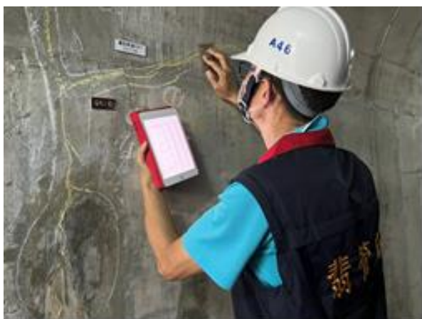
翡翠大壩內部廊道結構體巡檢
