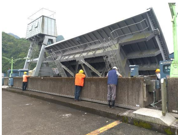
翡翠大壩放水閘門操作測試
