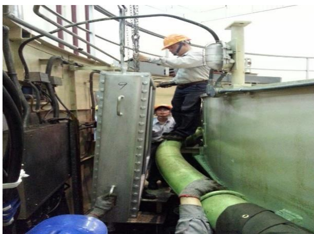
翡翠發電機組空氣冷卻器維護
