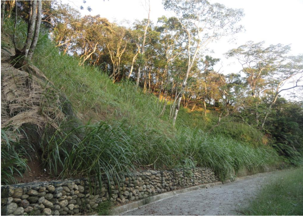
照片 2 103.10.20 翡翠水庫水土保持工程山坡地植生
