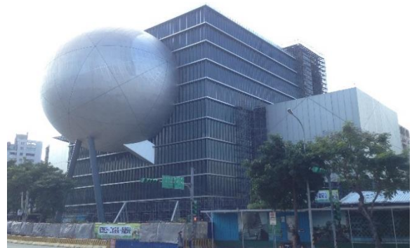
(照片 6) 臺北藝術中心興建工程施 工現況
