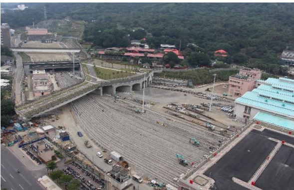
(照片 1) 捷運新莊線新莊機廠CK570J 區段標工程全區鳥瞰
