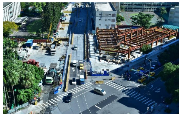
(照片 2) 萬大中和樹林線(第一期工程)植物園站國語實小共構大樓工區鳥瞰
