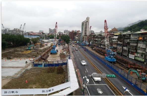
(照片 3)信義線東延段工程 CR580C 標廣慈/奉天宮站施工現況
