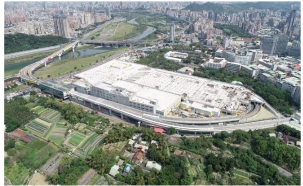
(照片 4) 環狀線第一階段 CF640 區 段標現況
