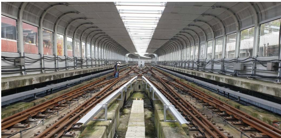
環狀線第一階段交叉橫渡線軌道鋪設完成
