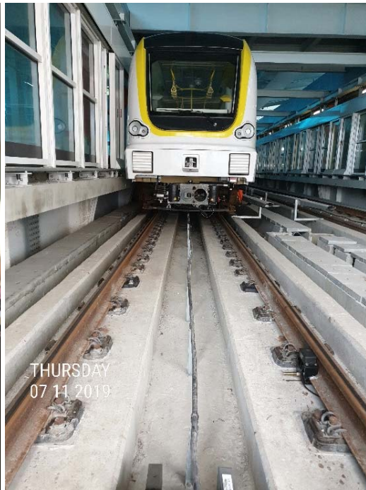
環狀線第一階段軌道鋪設完成
