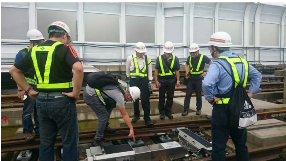
高架段道旁設備檢查
