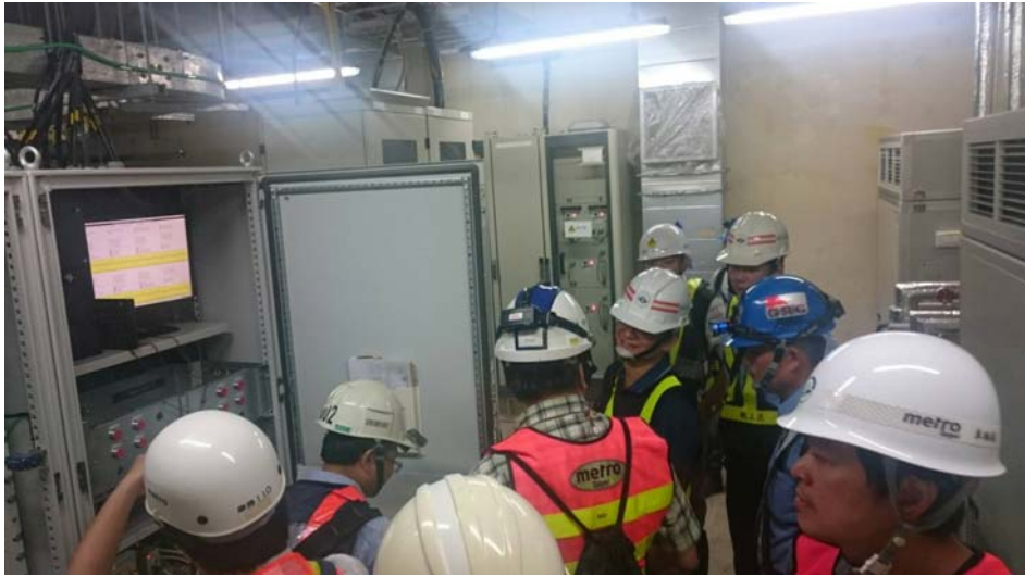
機房設備檢查
