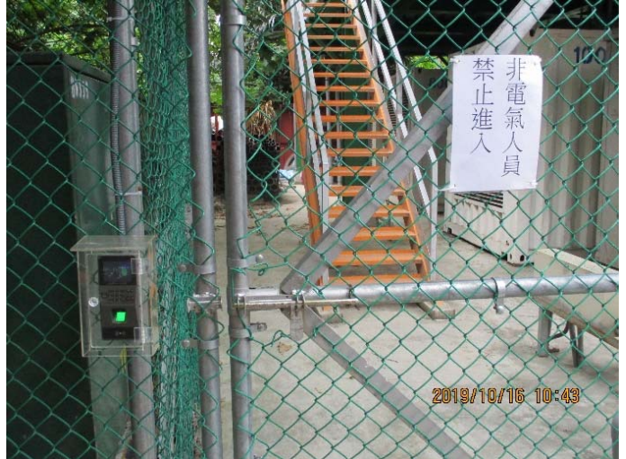
工地設置人臉辨識系統進行門禁管制、高壓變電站採取指紋辨識門禁管制。
