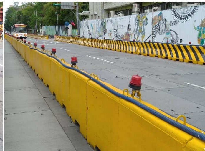
人行道紐澤西護欄電纜線以青龍管包覆，以防止感電風險。
