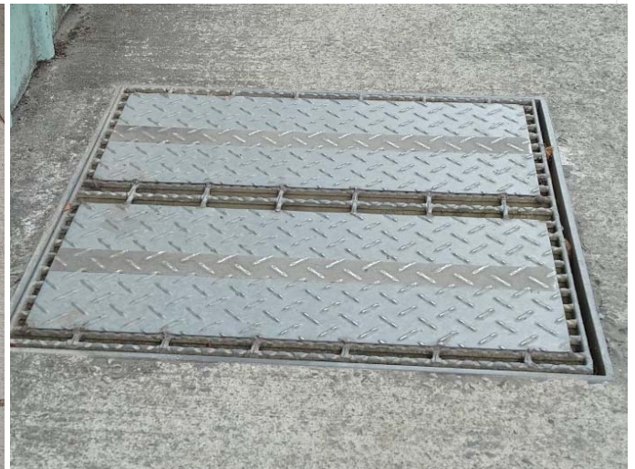
人行通道上之覆工板設置T型橡膠軟塞，水溝蓋設置止滑條，以防止著高跟鞋女性跌倒。
