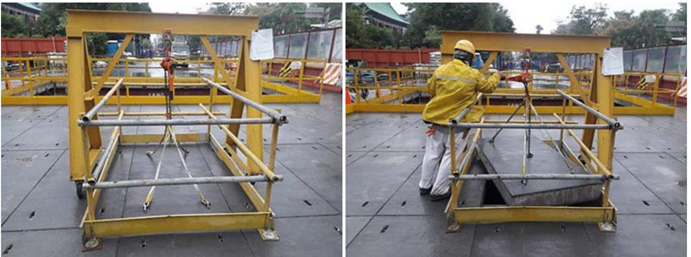
設計簡易式覆工板吊掛設施，防止人員墜落。
