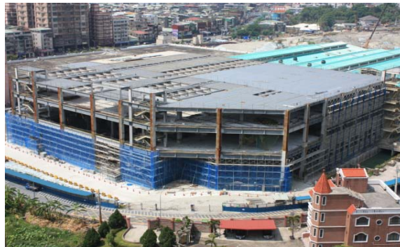
新莊機廠之維修工廠員工區鋼骨結構吊裝完成
