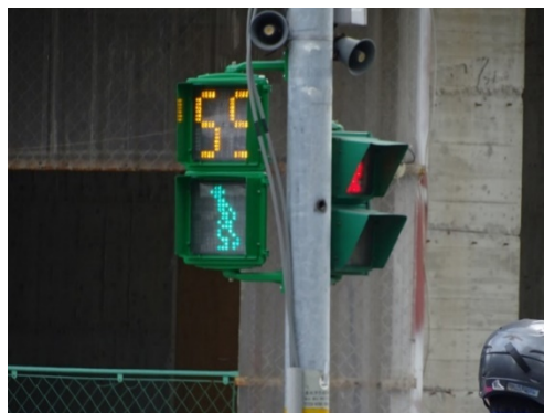
圖 4 30 公分放大型行人專用號誌（右方為現行 20 公分行人專用號誌）
