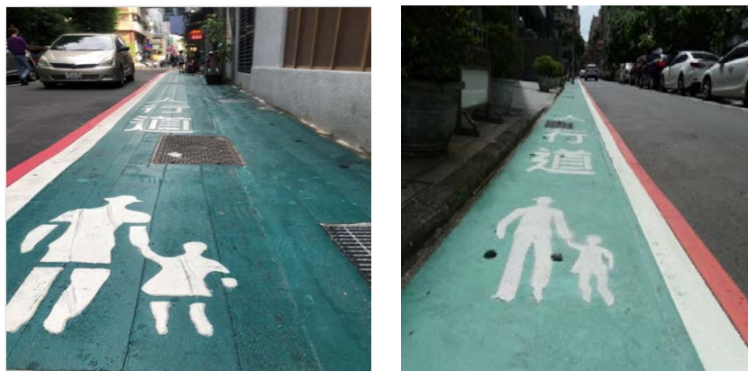
圖 5 標線型人行道傳統(熱拌)既有工法(左)與新工法(右)比較圖
