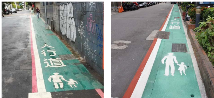
圖 5 標線型人行道傳統(熱拌)既有工法(左)與新工法(右)比較圖
